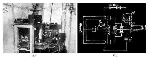
Fig. 3. Experimental setup (a) and Winnik–Zavoisky VHF transmitter circuit (b). Рис. 3. Экспериментальный стенд (a) и схема УКВ-передатчика Винника — Завойского (b)
