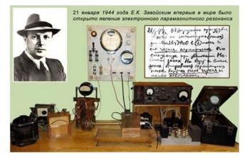
Fig. 4. Zavoisky's experimental set to study the electron paramagnetic resonance. Рис. 4. Экспериментальная установка Е. К. Завойского для изучения ЭПР
